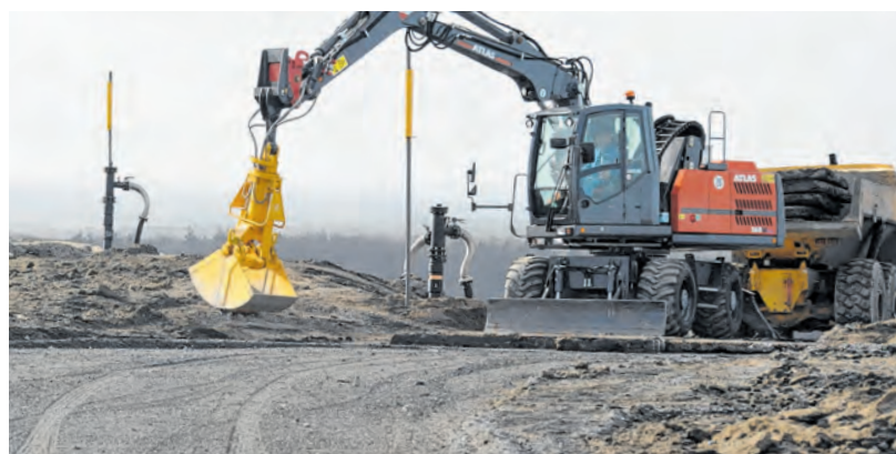
Die Ihlenberger Abfallentsorgungsgesellschaft lässt auf einem Hochplateau der Deponie eine Betriebsstraße anlegen. FOTO: JÜRGEN LENZ
